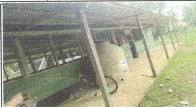
Foto 2: Se observa la estructura portante de las aulas en deterioro
